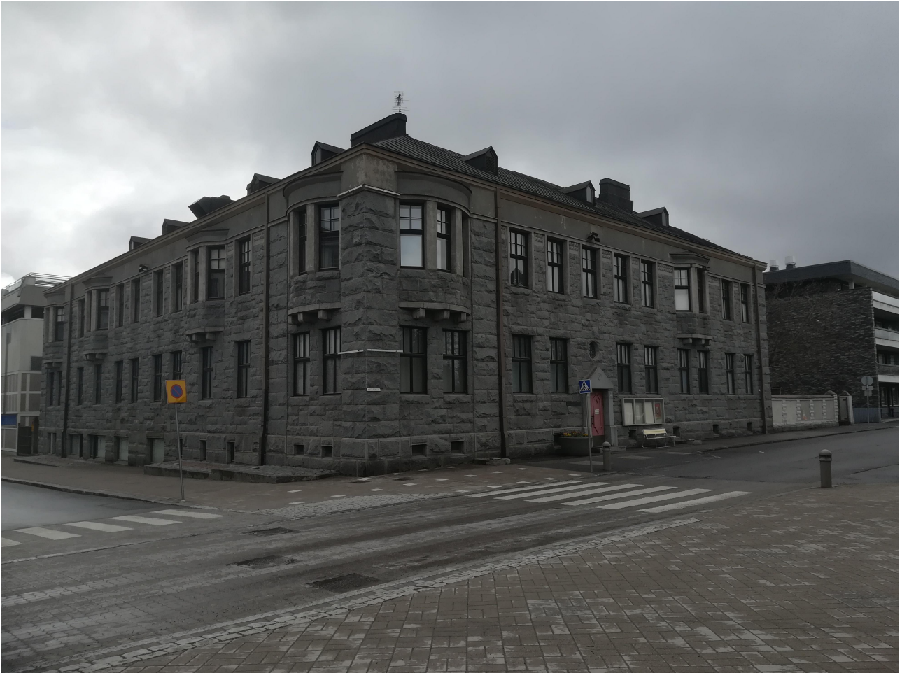
Kuva kaupunkikuvallisesti merkittävästä ja rakennushistoriallisesti arvokkaasta Graniittitalosta.
