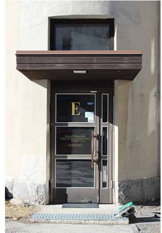
Kuvassa sisäpihan sisäänkäynti E-porrashuoneeseen. Ulko-ovi ja tasakatos ovat vuodelta 1975.
